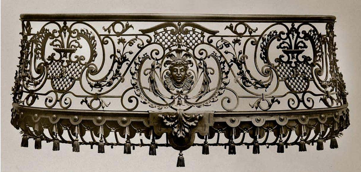
Schmiedeeisernes Balkongitter mit getriebenen Ornamenten für den Bau »Kugel« am Hof, Wien
